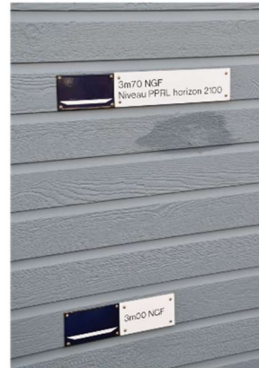
Pose de repères de niveau d'eau avec l'aléa 2010 de submersion, Port de Miquelon. Source : Xénia Philippenko, 2018
