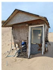
Abandon et dégradation d'une maison en cours d'ensablement
