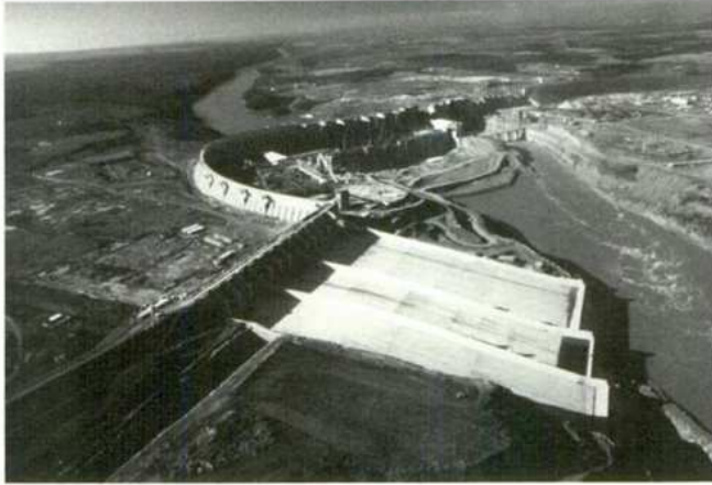
55. Construção da usina hidrelétrica de Itaipu.
