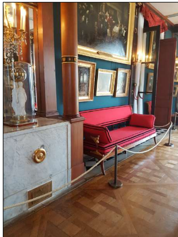
Système de chauffage par bouche d'aération dans les coffrages soutenant des colonnes d'acajou livrées par les frères Jacob, utilisé dans la Galerie (Salon de musique) du Château de Malmaison, Avril 2017, Photographies personnelles
