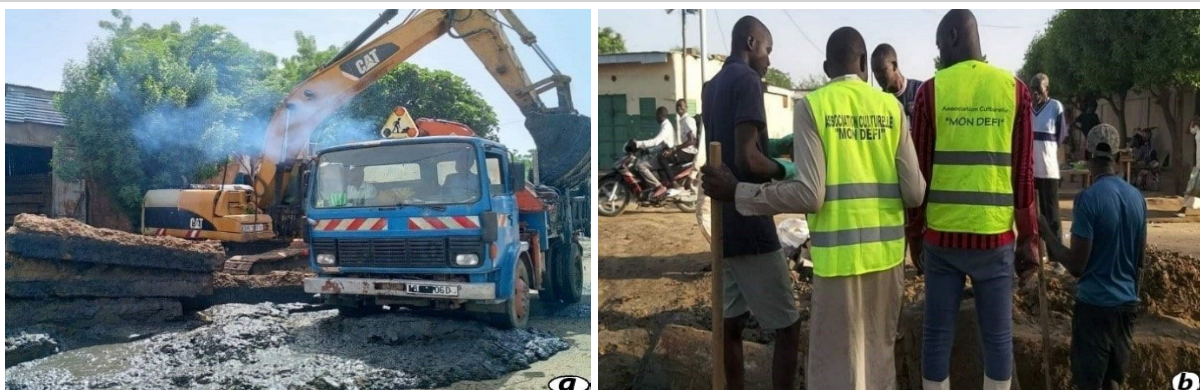
Planche.21 : (a) Curage de caniveaux par la Commune au centre-ville, (b) Creusage de caniveaux par les jeunes en zones précaires, Cliché : Djabaye2020
