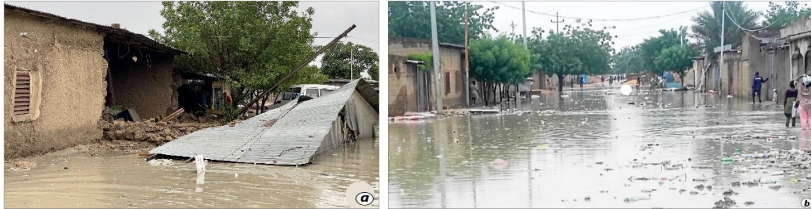
Planche.15 : (a) Ridina, crue 2020 : maison en banco écroulée, tôle (b) noyée dans boue et déchets (cliché : Djabaye, 2022).
