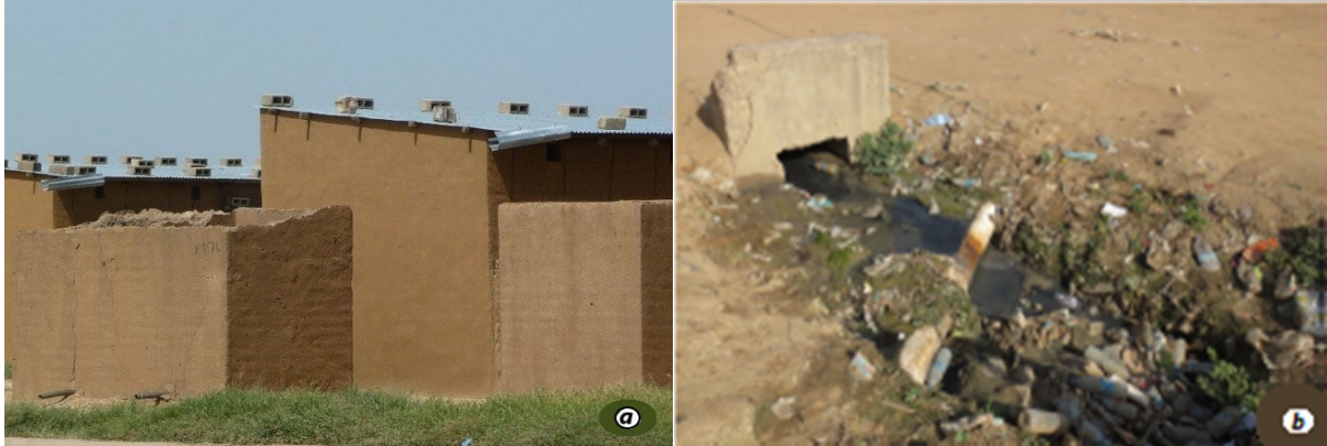
Planche.11 : (a) Les matériaux basiques tels que les briques crues concernent 2/3 de l'habitat – (b) : Canal endommagé, faible pression et pollution de l'eau – cliché : Djabaye 2022
