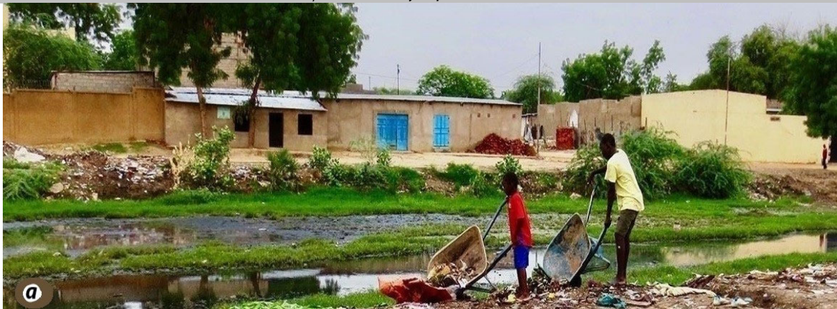
Planche.9 : (a) Dépôts sauvages le long du canal des Jardiniers, créant une nuisance pour les piétons. (b) Vue du canal des Jardiniers, illustrant son état actuel. (c) Plan du canal, montrant son envergure et son partage entre les 3 communes (3 e , 5 e et 6 e arrondissement) - Cliché : Djabaye 2021 & Tchainfor/AFD 2019.
