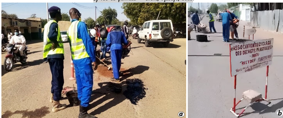
Planche.27 : a) Mobilisation des RECYDEP-Innov dans une activité de colmatage au 5 ème arrondissement de N'Djaména, b) Vue du panneau – Cliché, Djabaye, 2023.
