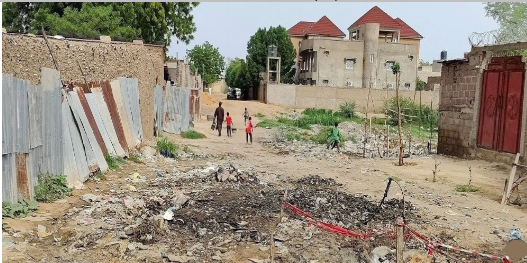
Photo.9 : Axes tertiaires où la marche à pieds est rendue difficile par l'état de la voirie, de même que le passage des véhicules de collecte — Cliché : Djabaye 2023.
