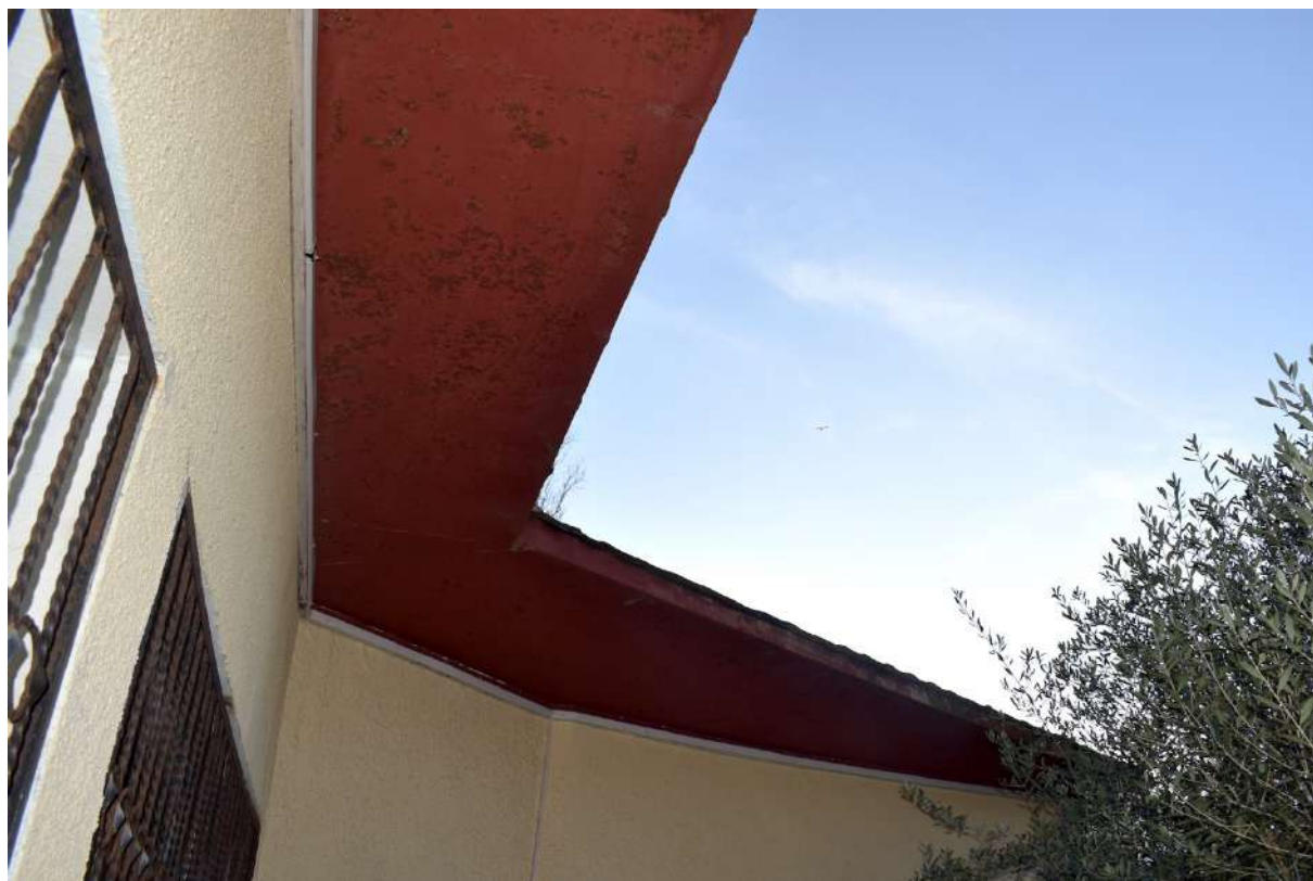
Figure 78 - Dortoir de l'INSSTS. (1967). Toiture "gauche". Photo prise par l'auteur.
