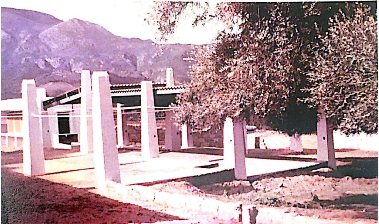
Figure 73 – Camp de toile à Tipasa. 1964. Cour centrale. In : Jean- Jacques DELUZ, Jean- Jacques Deluz Architecte Urbaniste. Illustration des études et travaux, 2004. Fonds Deluz Centre d'étude diocésain d'Alger, Boite 1 chemise 7.
