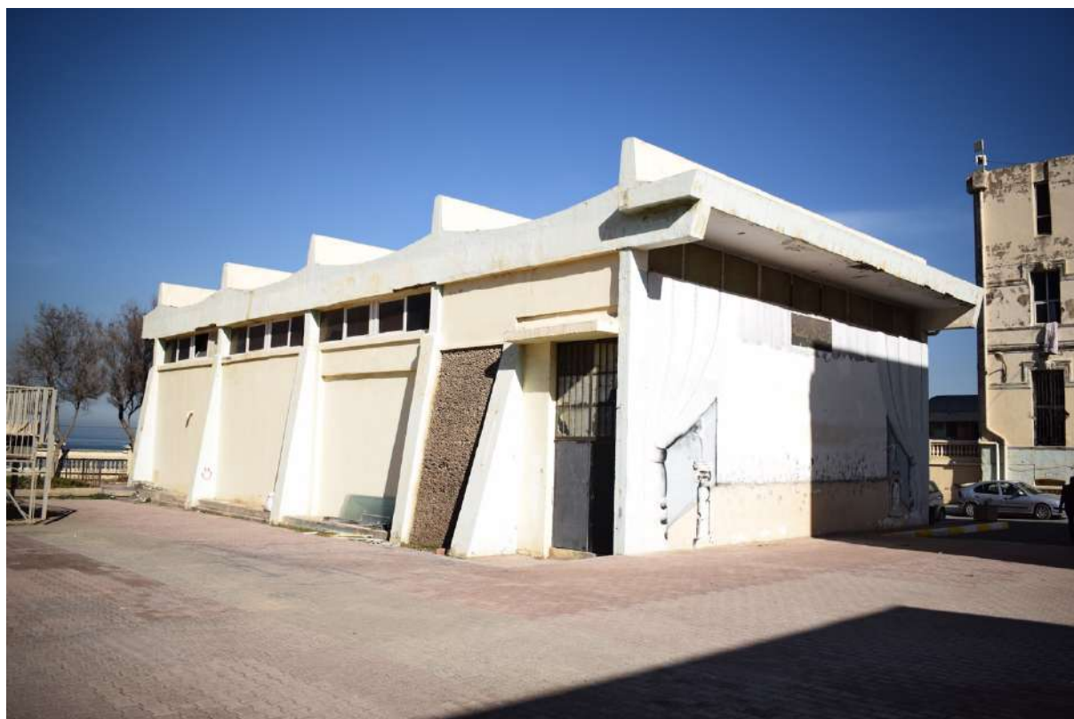
Figure 81 - Institut National d'Art dramatique (1964-1967). Le gymnase. Photos prises par l'auteur.
