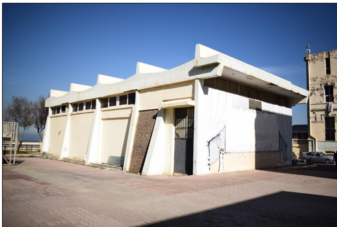
Figure 59 : Institut National d'Art dramatique (1964-1967). Le gymnase. A gauche de l'entrée le mur en béton cyclopéen. Photo prise par l'auteur.
