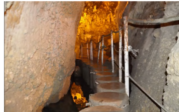
Passage sur plots en ciments
