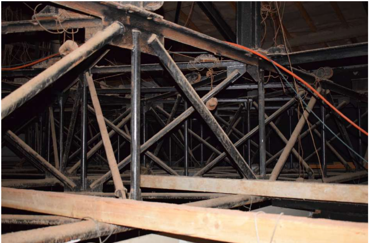
Figure 86 - - Institut National d'Art dramatique (1964-1967). Gril du théâtre d'essai. Photo prise par l'auteur.
