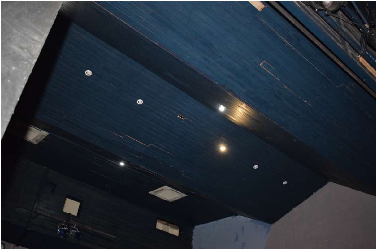
Figure 84 - Institut National d'Art dramatique (1964-1967). Amphithéâtre. Plafond acoustique. Photo prise par l'auteur.
