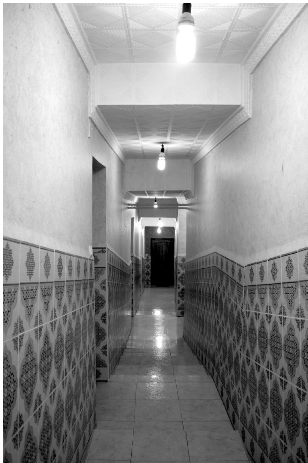
Figure 80 - Dortoir de l'INSSTS. (1967). Couloir central en "pas d'âne". Photo prise par l'auteur.
