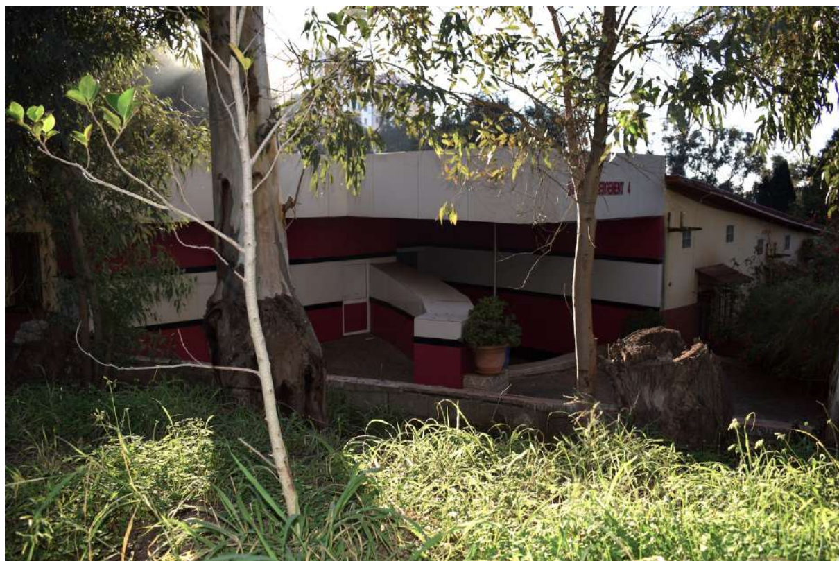
Figure 79 - Dortoir de l'INSSTS.(1967) Entrée principale 1 . Photo prise par l'auteur.
