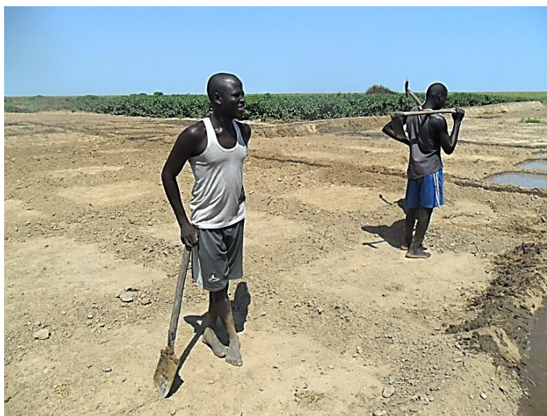
Photo n° 2 : Aménagement des parcelles de maraîchage (construction des casiers et chenaux d'irrigation)
