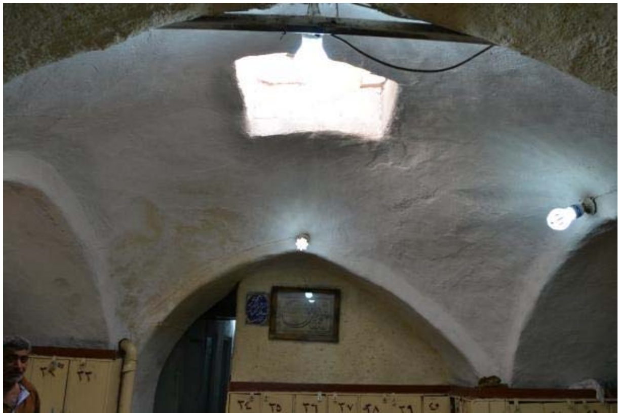
Figure 293 : cl. Le toit de la salle principale
