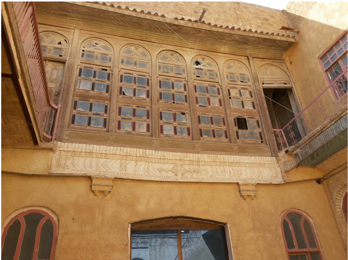
Figure 238-a : La cour de la maison de Mahdī Salmān dans sa forme d'origine
