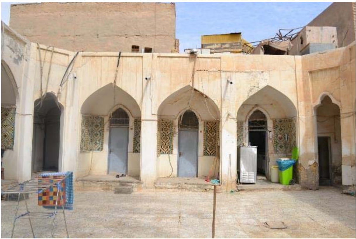
Figure 221-b : cl. La cour intérieure de la Madrasa al-Hindi
