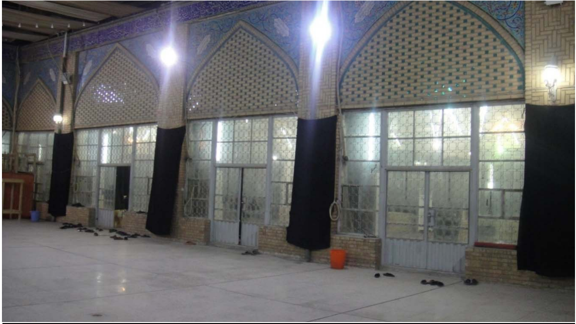
Figure 156: La façade Sud de la mosquée d'al-Hindi (IAPN)
