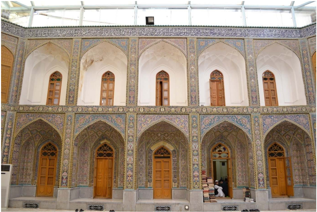
Figure 208: La façade Est de la cour de la Madrasa al-Sayyid Muhammad Kāzim al-Yazdī
