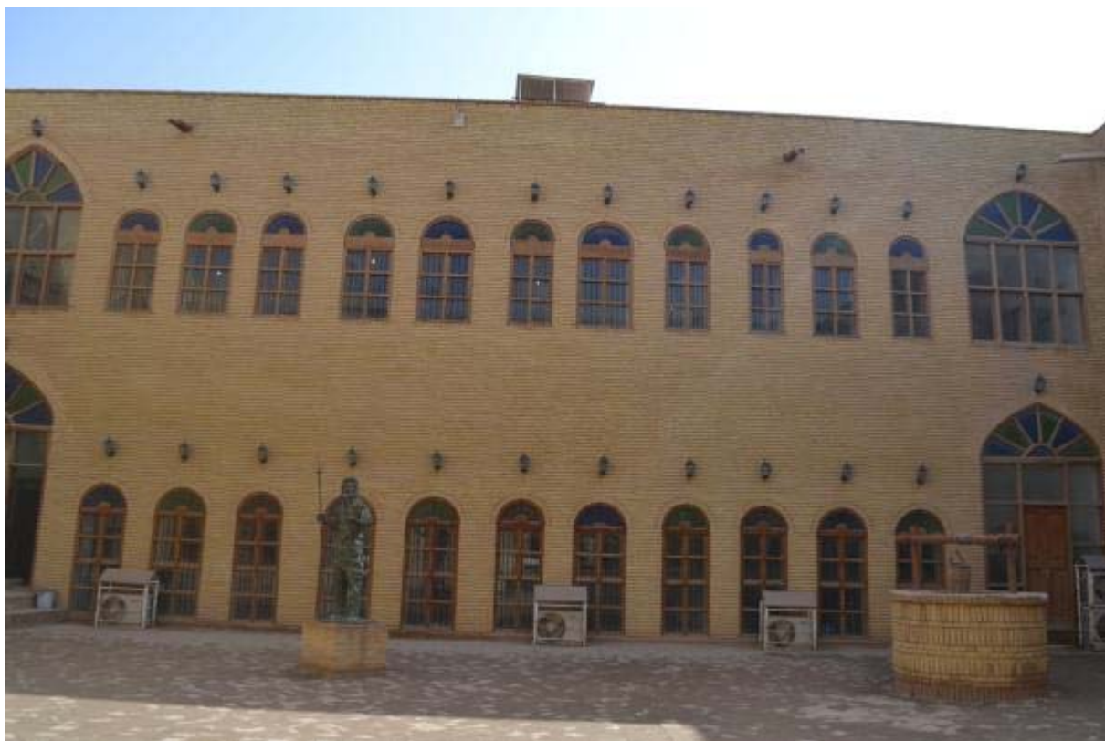
Figure 277-b : l. cl. La cour intérieure du Khān al-Shīlān
