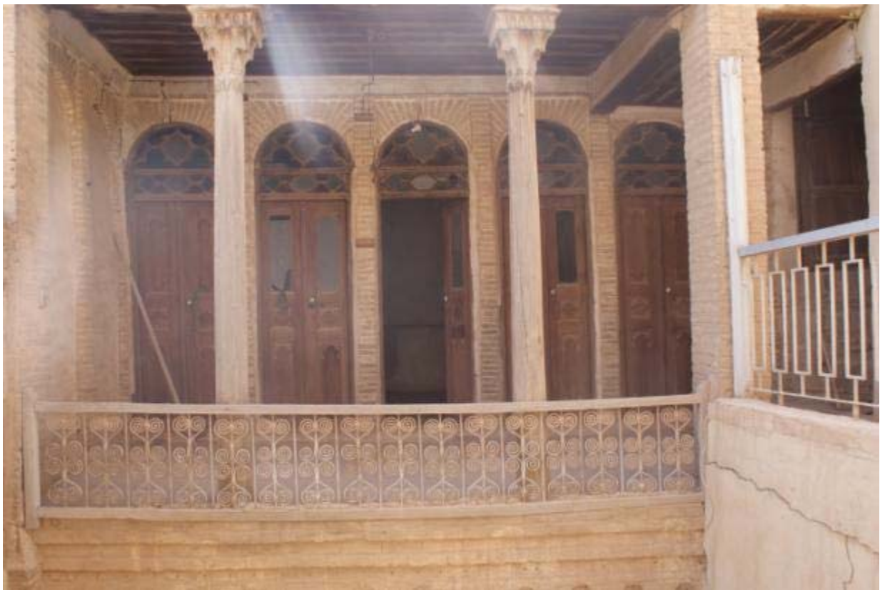
Figure 258 : Les façades intérieures de la maison al-Gharawī (IAPN)
