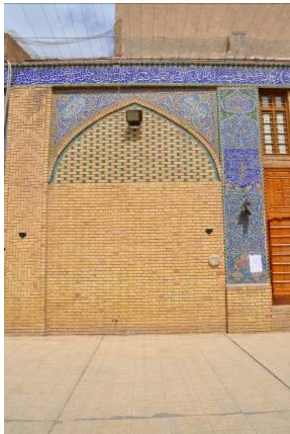
Figure 155: Une partie de la façade Nord de la mosquée d'al-Hindī
