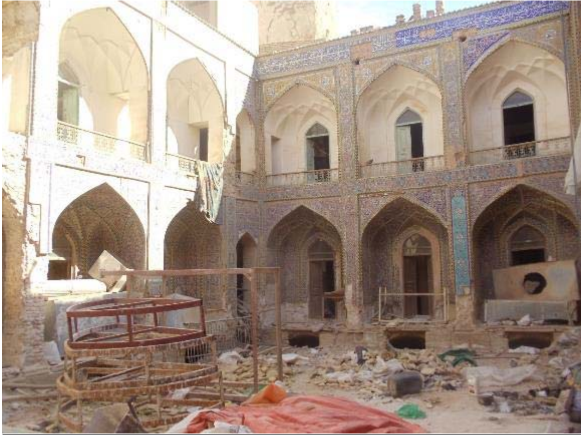
Figure 219 : La façade intérieure d'al-Madrasa al- Ākhūnd al-Waṣṭa(Dewan)
