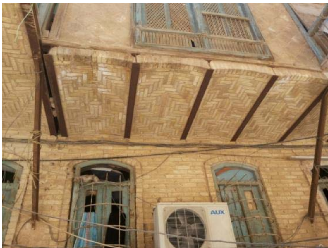
Figure 247 : Les façades de la maison 'Alī Shamsa
