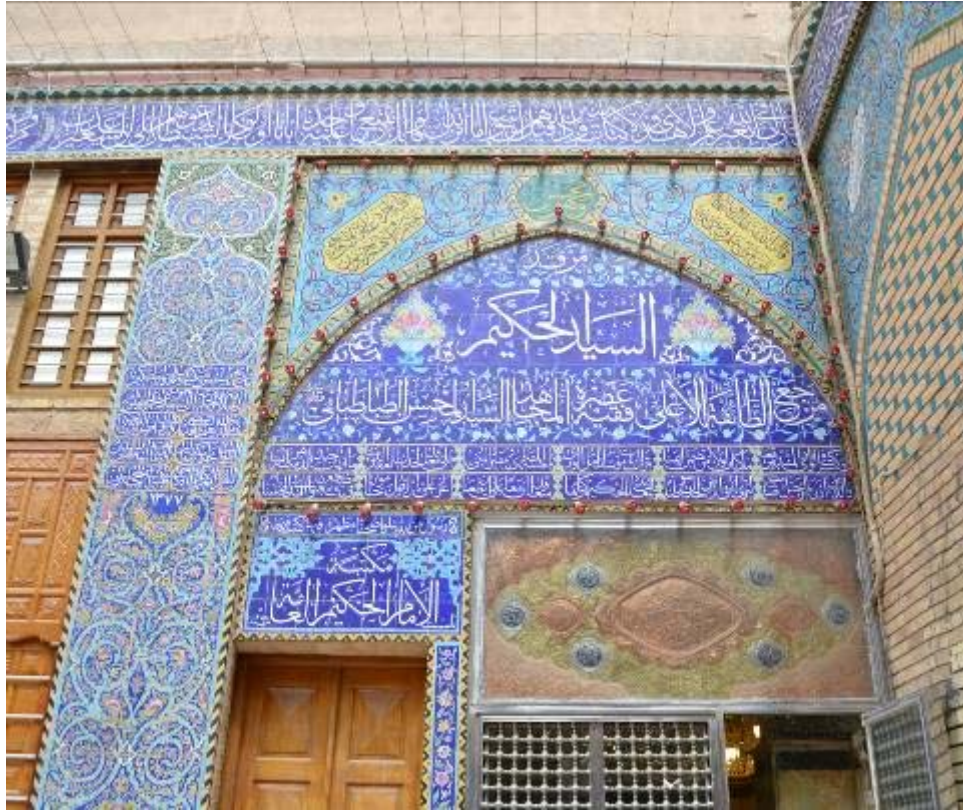
Figure 154: La façade de la tombe d'al-Sayyid al-Hakīm dans la mosquée d'al-Hindī
