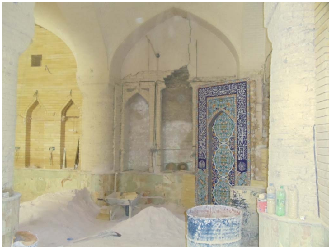
Figure 171: La mosquée de Souk al-Masābih pendant les travaux (Dewan)
