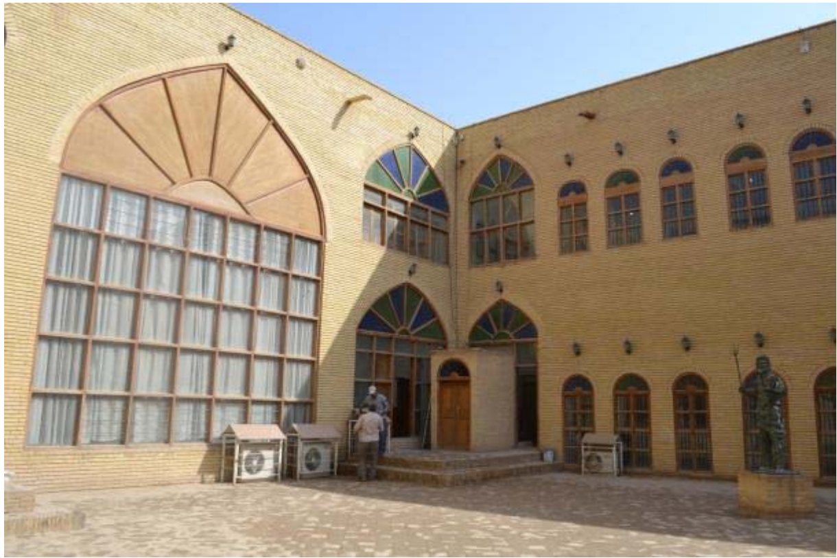
Figure 279 : l. cl. La façade Nord du Khān al-Shīlān
