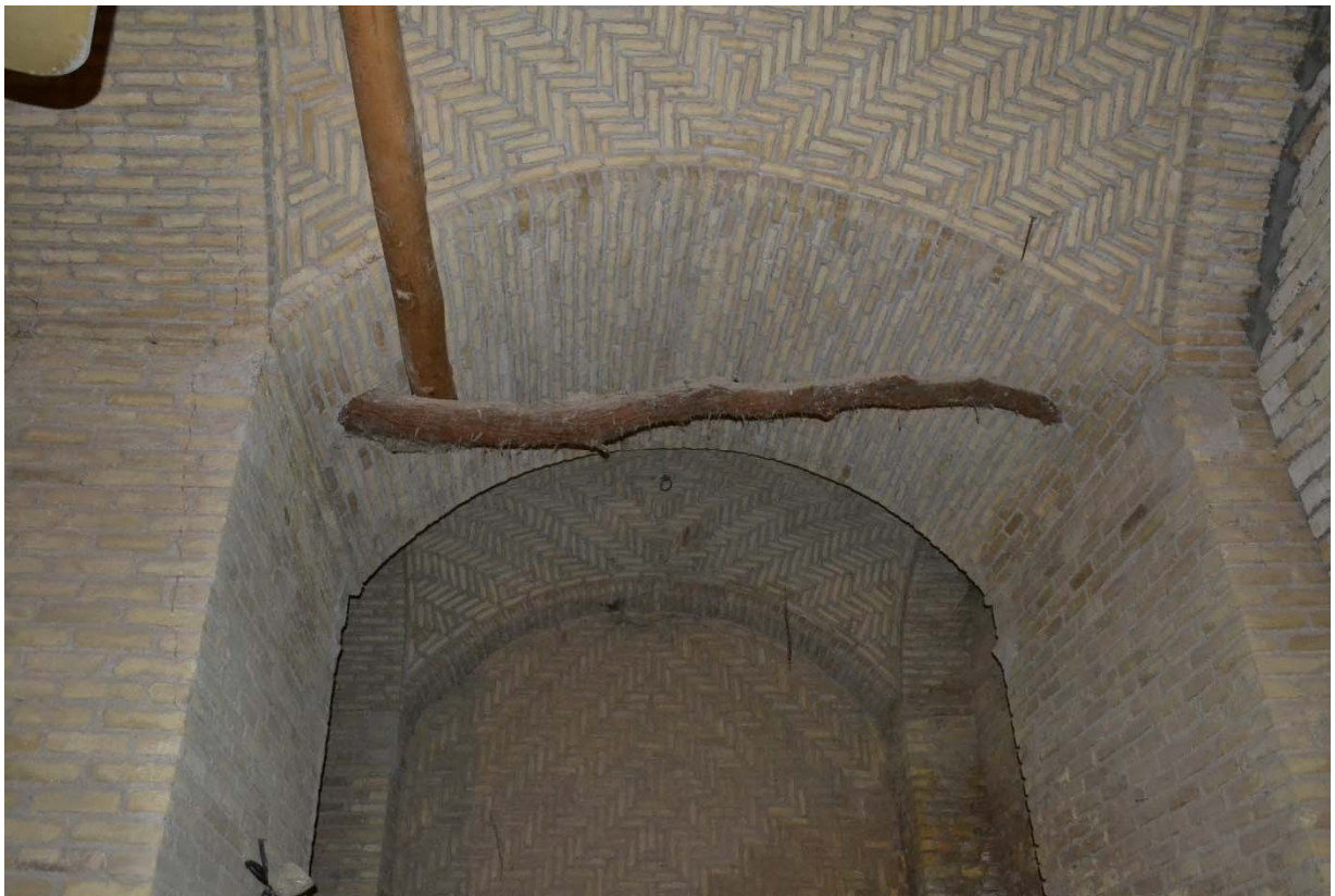
Figure 239 : Le sous-sol de la maison de Mahdī Salmān
