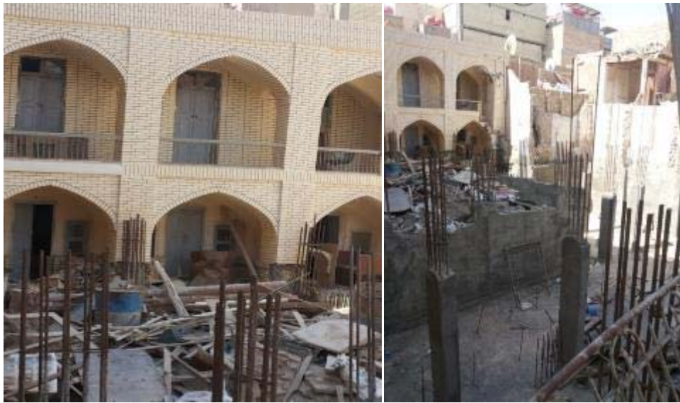
Figure 182: La Madrasa al-Mu'tamid avant et pendant les travaux (IAPN)
