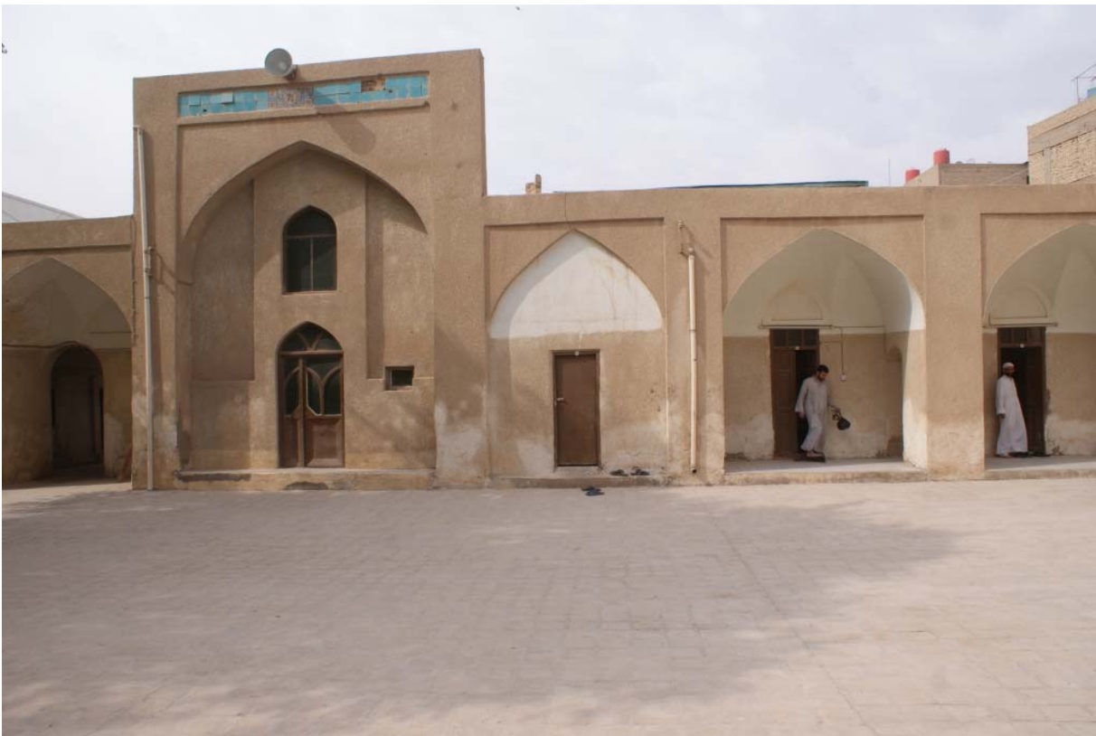
Figure 179: La cour intérieure de la Madrasa al-Sadr al-'Azam (Dewan)
