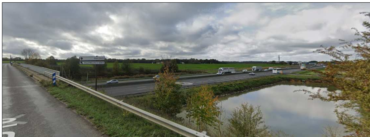
Figure 93: Vue du pont de la rue de Tournan à Jossigny au-dessus de l'autoroute A4 avec en arrière-plan la forêt domaniale de Ferrières (M. Jussaume, 2022)
