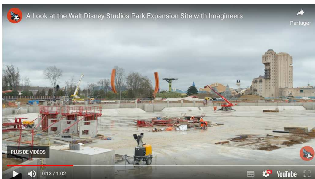
Figure 64: Vue du chantier du lac artificiel ZAC des Congrès (EPA France, 2023)
