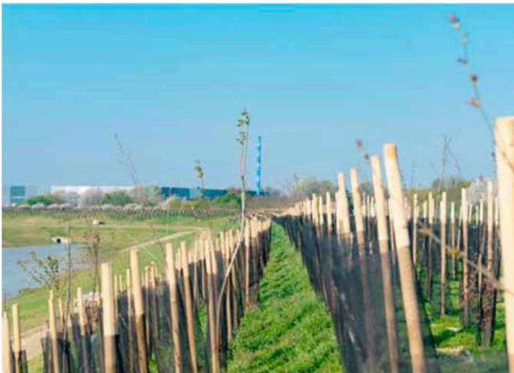
Figure 26: Mise en place de merlons plantés dans le parc de l'A5 de l'OIN Sénart (EPA Sénart 2020, p30)
