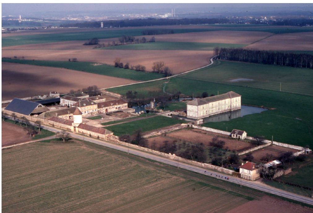
Figure 106: Vue aérienne de la ferme du Génitoy dans les années 1980 (Phan, 2008)
