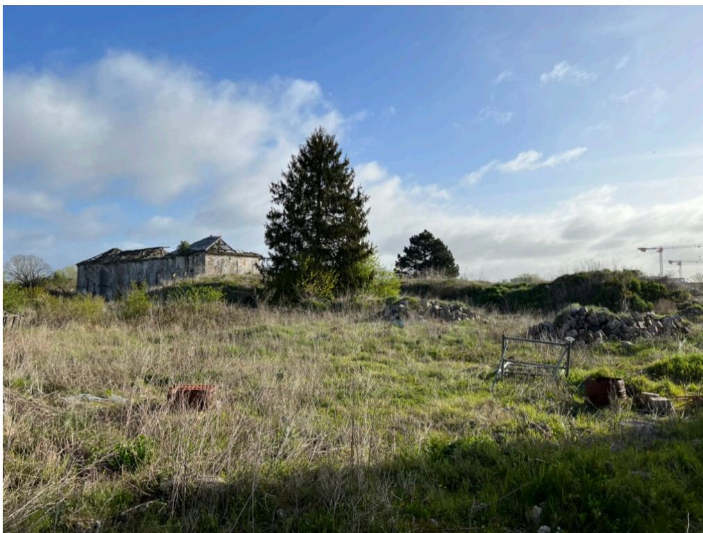
Figure 107: Les ruines du château et les déblais (M. Jussaume, avril 2023)
