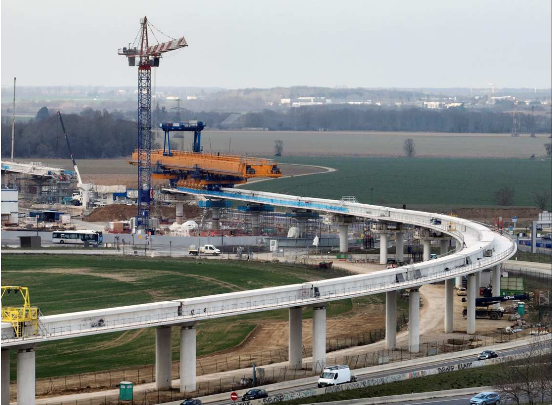
Figure 58: Construction de la ligne 18 (Grand Paris Express, mars 2023)
