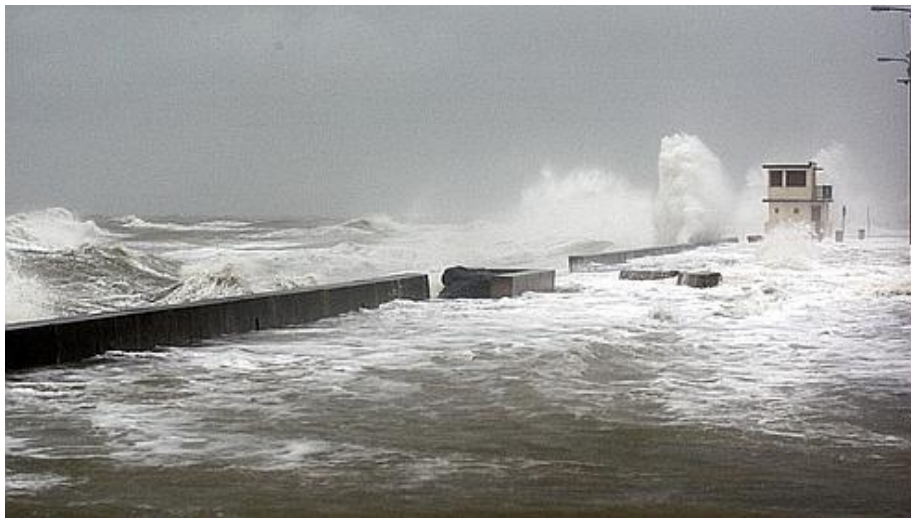
Figure 3.57. La digue de Ver-sur-Mer (source : Libération , 1 er mars 2012)
