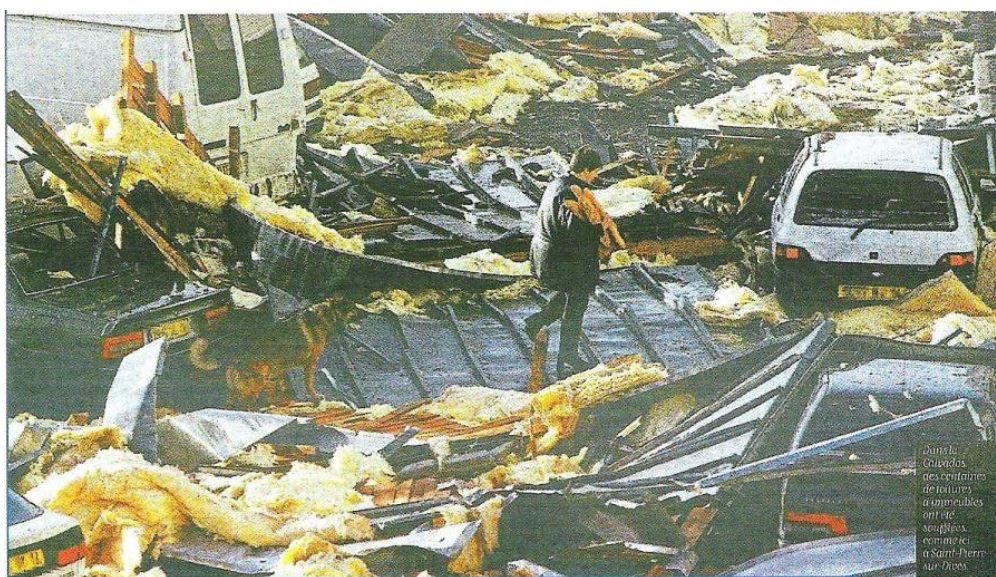
Figure 3.51. Toitures d'immeubles arrachées à St-Pierre-sur-Dive, Libération 27/12/1999 (source : Séchet, 2004)
