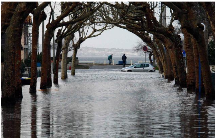
Figure 3.60. Une rue d'Andernos après le passage de Xynthia (source : Aujourd'hui en France , 1 er mars 2010)
