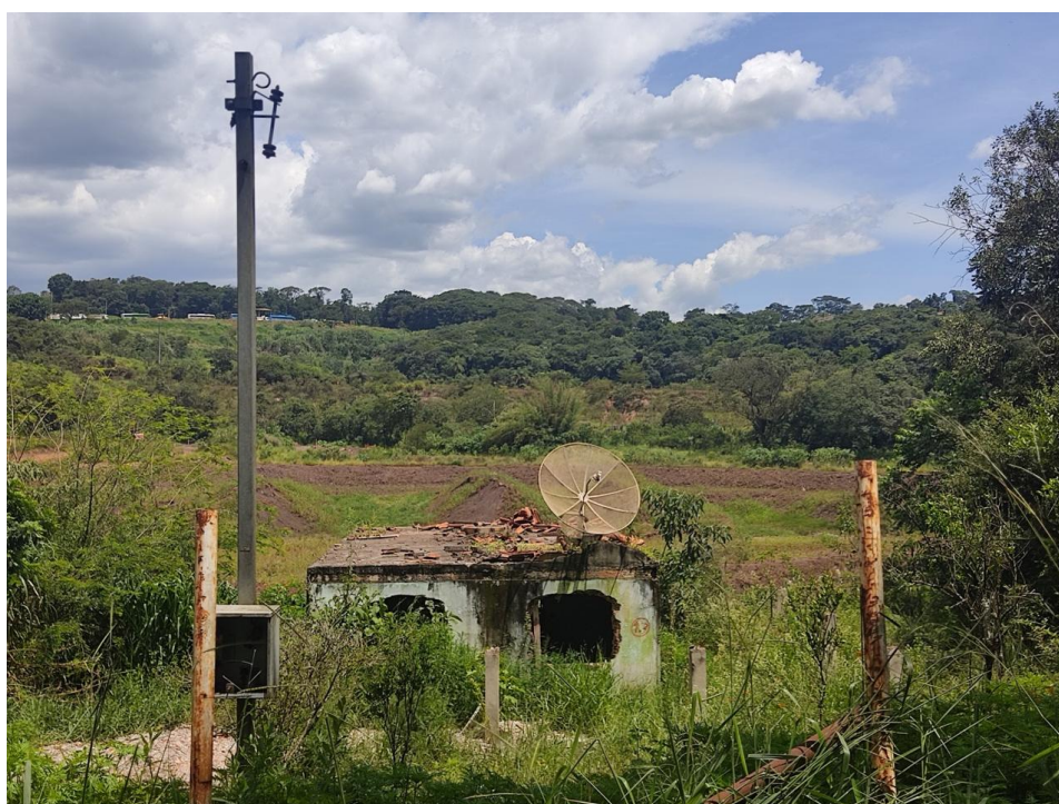
Fotografia 3 - Casa atingida pela lama de rejeitos no Parque da Cachoeira.
