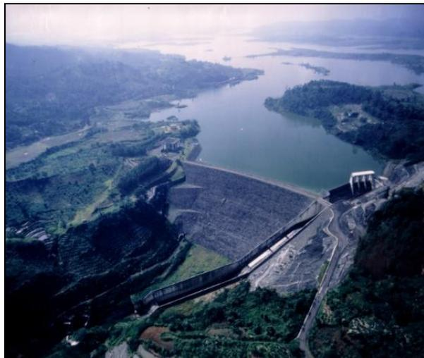
Bandung, a été mis en service en 1986. Sa hauteur de 99 mètres en remblai retient un réservoir de  $875 \times 10^6 \text{ m}^3$ . Son principal objectif est d'être dédié à la production d'électricité disposant d'une capacité installée de 700 MW pouvant être étendue à 1 400 MW à l'avenir. Il assure aussi l'approvisionnement en eau et abrite une activité piscicole.
