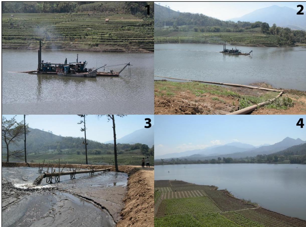
**Figure 59 : Extraction des sédiments dans le réservoir par aspiration dans le réservoir de Selorejo**
