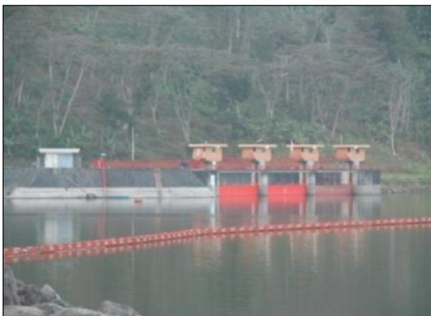
Le barrage Selorejo (Fig.52) quant à lui ne se trouve pas directement sur le cours du Brantas, mais sur un de ses principaux affluents, la rivière Konto. Mis en service en 1971 avec un volume initial de  $62,3 \times 10^6 \text{ m}^3$ , il assure lui aussi le contrôle des crues, l'irrigation des terres agricoles et la production hydro-électrique.
