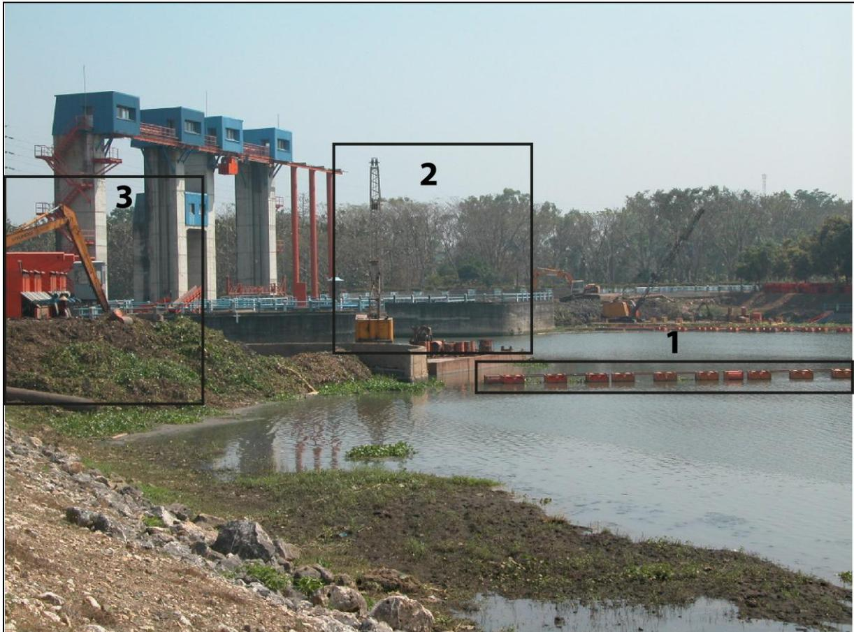
**Figure 58 : Dispositif de dragage devant la conduite forcée du barrage de Sengguruh**
