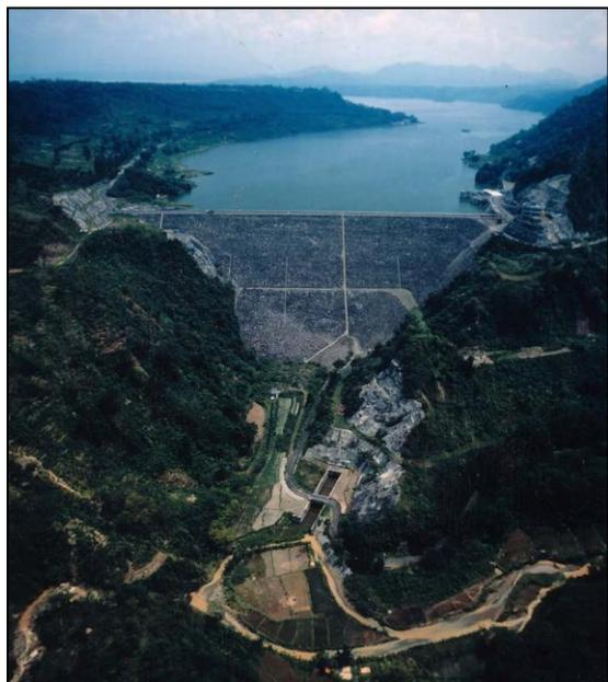
et a été mis en service en 1988. Situé à 100 km au sud-est de Jakarta, ce barrage en remblai d'une hauteur de 125 mètres a comme fonction principale la production hydroélectrique sous l'autorité de PLN (compagnie d'état d'électricité). La centrale a été réalisée en deux phases, la seconde étant achevée en 1998 et s'avère être la plus grande centrale hydroélectrique d'Indonésie, avec une capacité totale installée de 1 008 MW et une production annuelle de 1 426 GWh.
