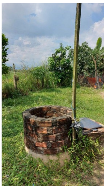
Figure n°72 : Puit d'eau douce artisanal construit par un ménage sur sa parcelle en plaine, Tỉnh Trà, district de Sơn Tịnh, province de Quảng Ngãi. Source : photographie de l'auteure, janvier 2022.
