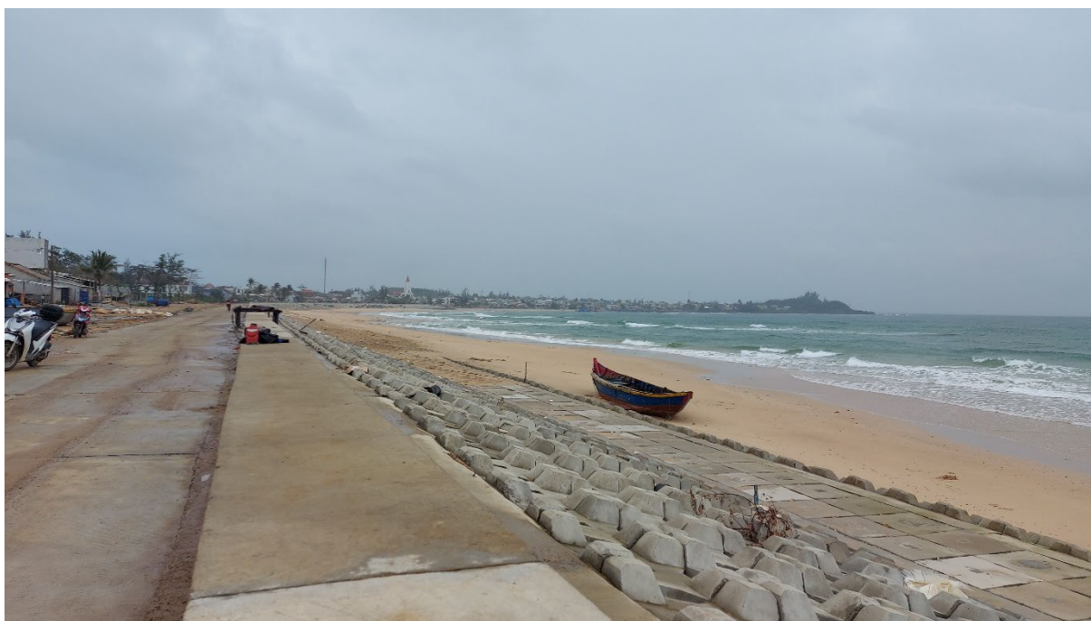
Figure n°56 : Brise-lames et digue sur la côte de la commune de Bình Hải, district de Bình Sơn, province de Quảng Ngãi. Source : photographie de l'auteur, janvier 2022.
