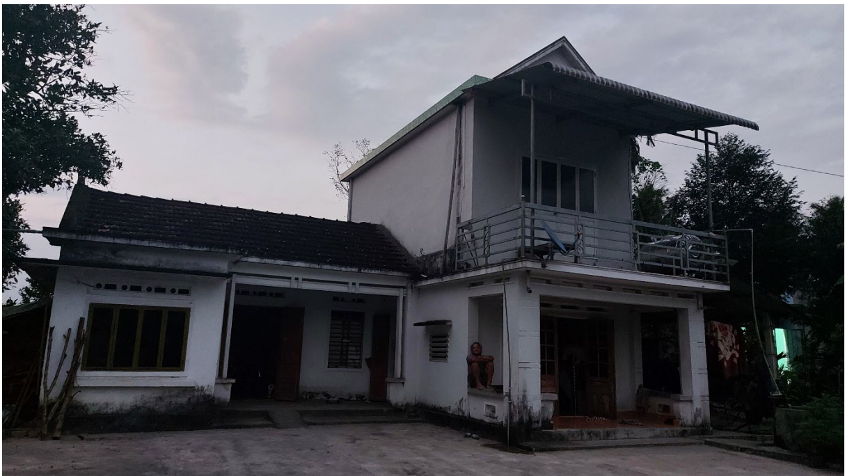
Figure n°59 : Maison située en fond de vallée dans la commune de Hành Tín Đông, district de Nghĩa Hành, province de Quảng Ngãi. La maison a été surélevée d'un étage avec l'aide d'allocations publiques suite à l'inondation de 2020. Source : photographie de l'auteure, janvier 2022.
