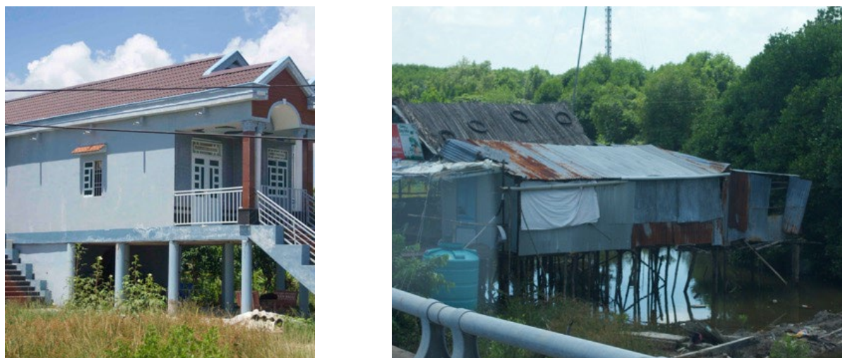
Figure n°41 : Bâtiments sur pilotis dans la province de Cà Mau, à la pointe sud du delta du Mékong. Source : photographies de l'auteurs, octobre 2019.
