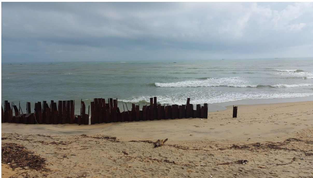
Figure n°55 : Digue temporaire sur la côte de la commune de Nghĩa An, dans la municipalité de Quảng Ngãi, province de Quảng Ngãi. Source : photographie de l'auteur, janvier 2022.
