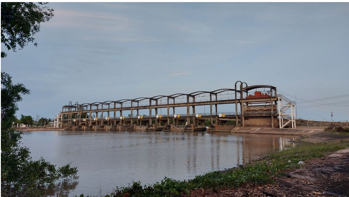
Figure n°54 : Barrage-écluse de Ba Lai, dans le district de Bình Đại, province de Bến Tre. Source : photographie de l'auteure, mars 2022.
