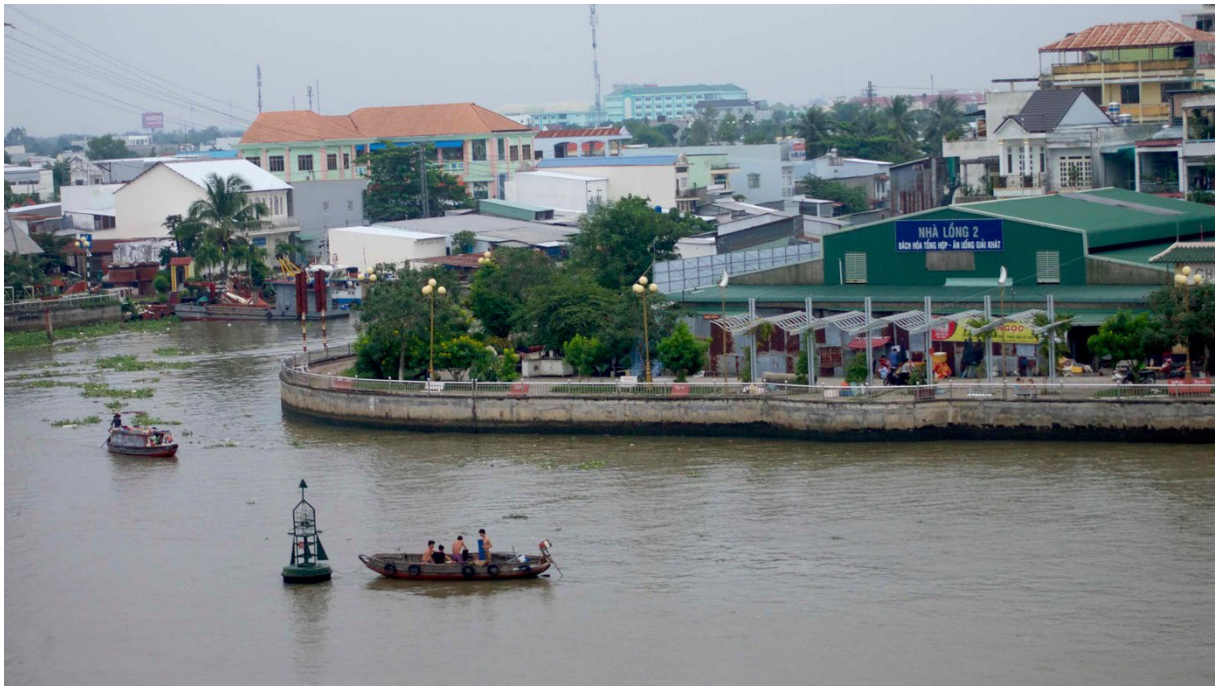
Figure n°63 : Endiguement des berges de la rivière Cần Thơ dans la périphérie sud-ouest de la municipalité de Cần Thơ, projet achevé financé par la Banque Mondiale. Quartier Lê Bình, district de Cái Răng, municipalité de Cần Thơ. Source : photographie de l'auteure, novembre 2019.
